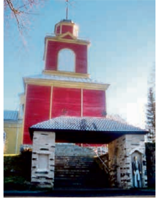
Lehtimäen kirkon erillinen kellotapuli on rakennettu 1835 (Abraham Hernesmaa) ja yhdistetty kirkkoon solarakennuksella 1895.
